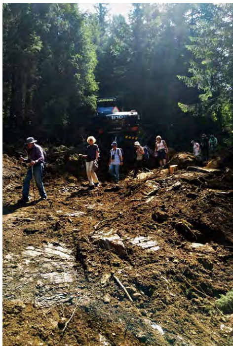
Der Wanderweg wurde zur Baustelle
