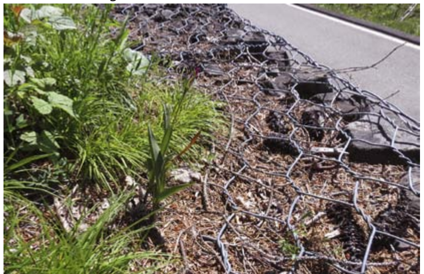
Abb. 13 Steinkörbe als Strukturen Mit Steinen gefüllte Gitterkörbe, die als Stützmauern eingesetzt werden, sind Strukturen der etwas besonderen Art. Doch erstaunlicherweise werden sie besiedelt, wie hier durch das Rote Waldvögelein ( Cephalanthera rubra ).
