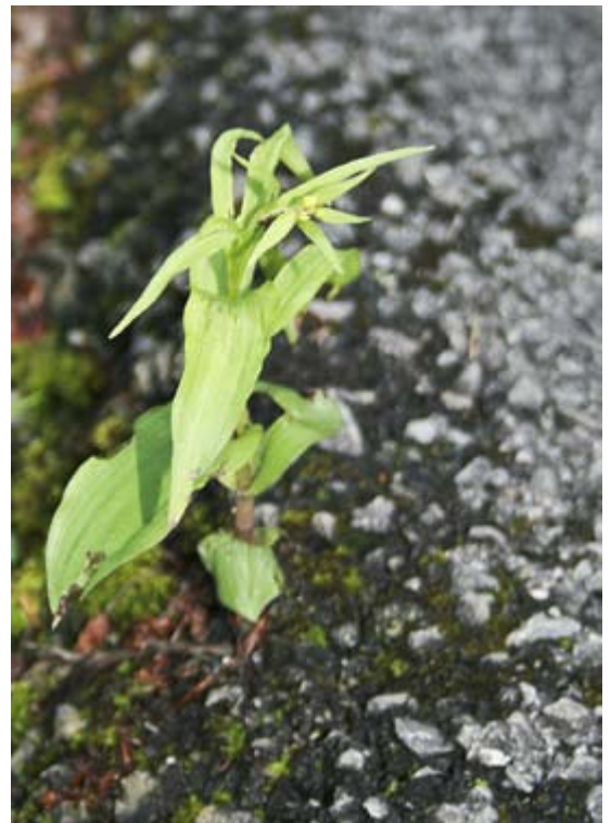
Abb. 6 Stendelwurz an der Grönstrasse Unter dem Asphalt liegt noch der frühere Kalkschotterbelag. Die Orchidee spürt das und nutzt den Minilebensraum, der durch einen Belagsschaden entstand.
