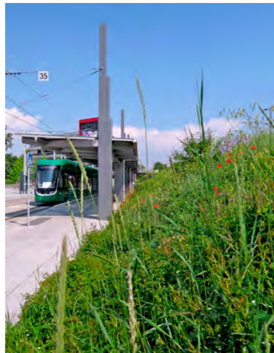
Bahnhof SNCF St. Louis (F)
